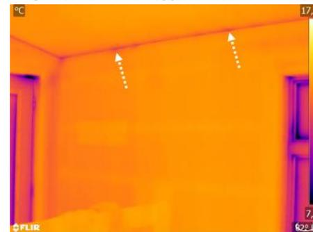
T-67: ( $\Delta P-$ ) Mouvements d'air mineurs à la jonction de l'enveloppe verticale et la toiture.
