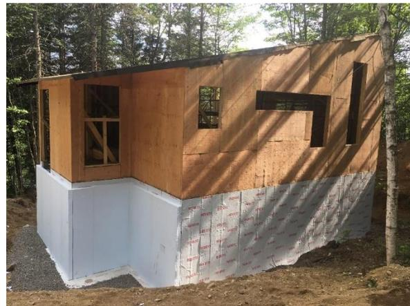
Même façade, alors que la membrane pare-air/vapeur (étanche aussi à l'eau) sert de protection au bâti durant les travaux. La pose de l'isolant de polyisocyanurate a débuté, de même que l'intégration des bris thermiques horizontaux.
