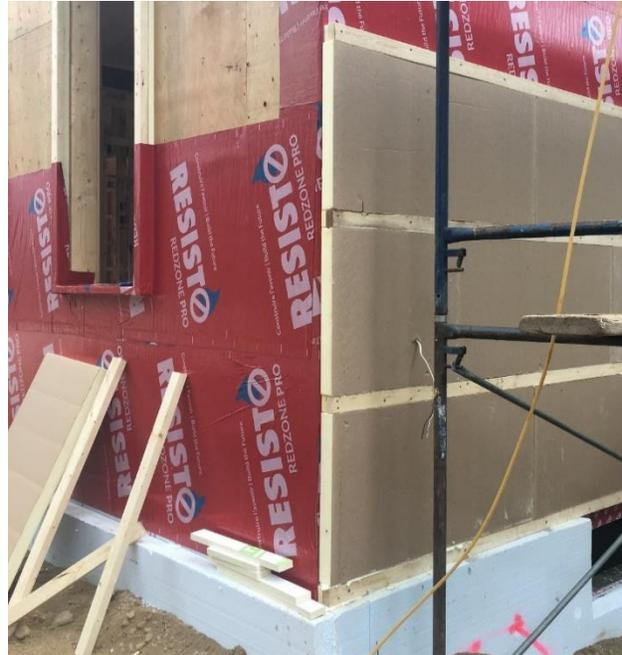
Ci-contre : protection temporaire du côté ouest, vents dominants. Ce type de précaution est rarement mis en place, et l'infiltration d'eau résultant des travaux de construction est dommageable lorsque l'assèchement est difficile.
